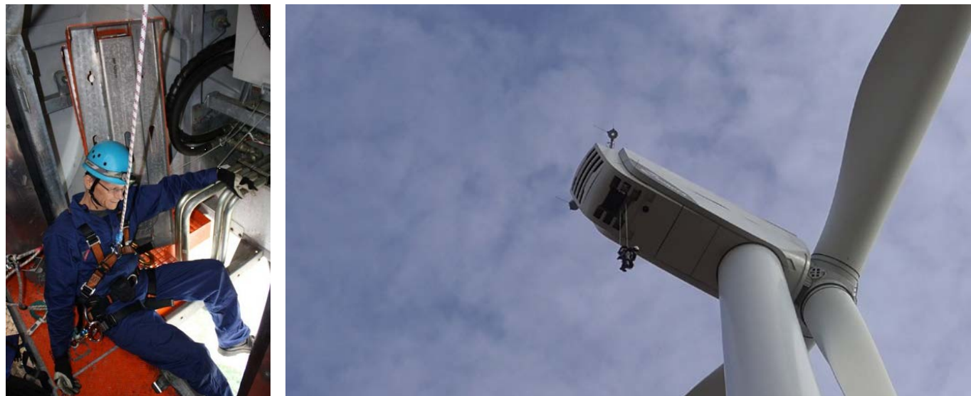
Figure 1 – Trappe arrière de la N117 pour évacuation d'urgence de la nacelle
